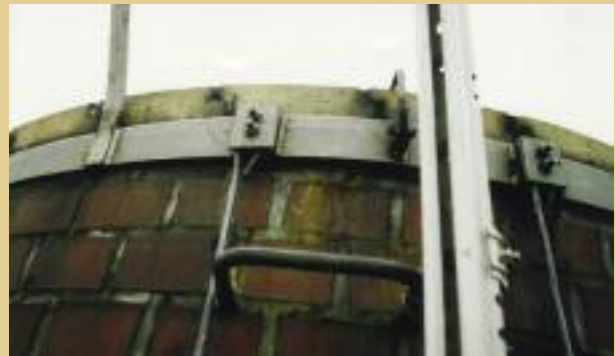
Bild 2: Fangring und Fangstangen sind wegen der chemischen Belastung in Edelstahl Werkstoffnummer 1.4571 auszuführen.
