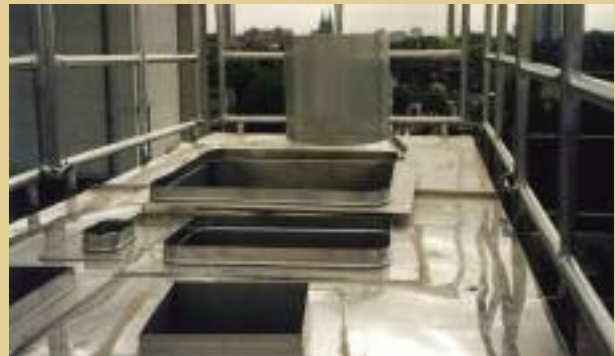
Bild 3: Metallabdeckung auf dem Schornsteinkopf.
