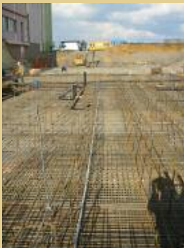
Bild 1: Fundamenterder auf unterer Bewehrung.
