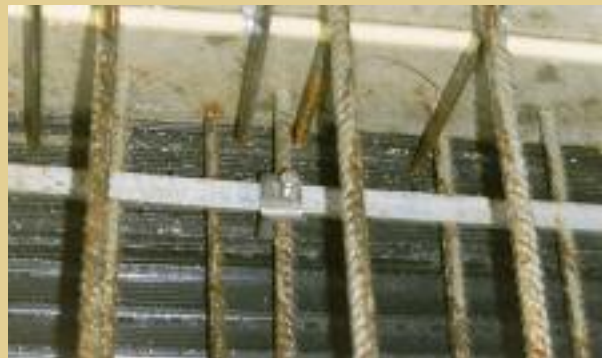
Bild 2: Anschluss an Bewehrung.
